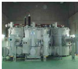
Трансформатор с элегазовой изоляцией
