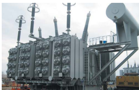
Трансформатор 345 кВ
