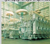
- Трансформатор стержневого типа
