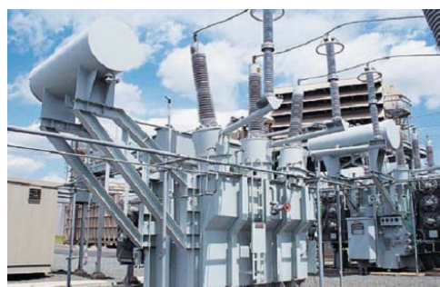
Трансформатор 230 кВ
