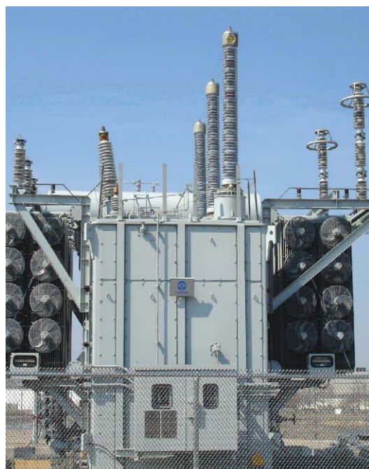
Трансформатор 345 кВ
